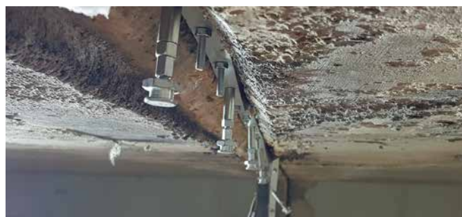
Eingebautes DESOI Quick Seal in einer Fuge | DESOI Quick Seal intégré dans un joint
