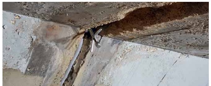
DESOI Quick Seal setzen, beginnend mit dem Rechteck-Stahlpacker Posez le scellement rapide DESOI, en commençant par l'obturateur rectangulaire en acier.
